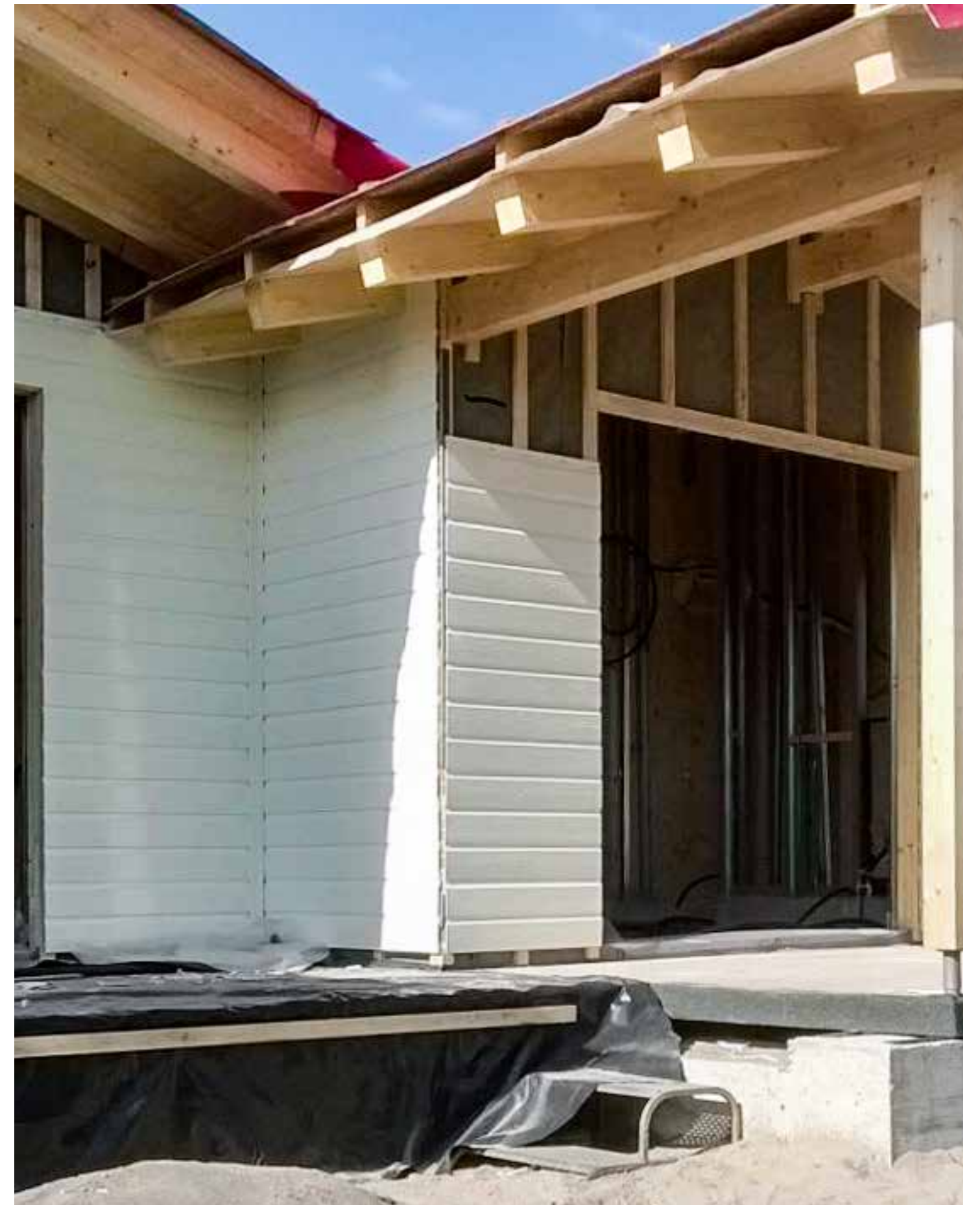
Installazione a Parete Orizzontale su distanziali per casa in bioedilizia - ISOMUR - Legno Bianco Lucido Horizontal Wall Installation On Spacer Profiles for green building home - ISOMUR - Glossy White Wood
