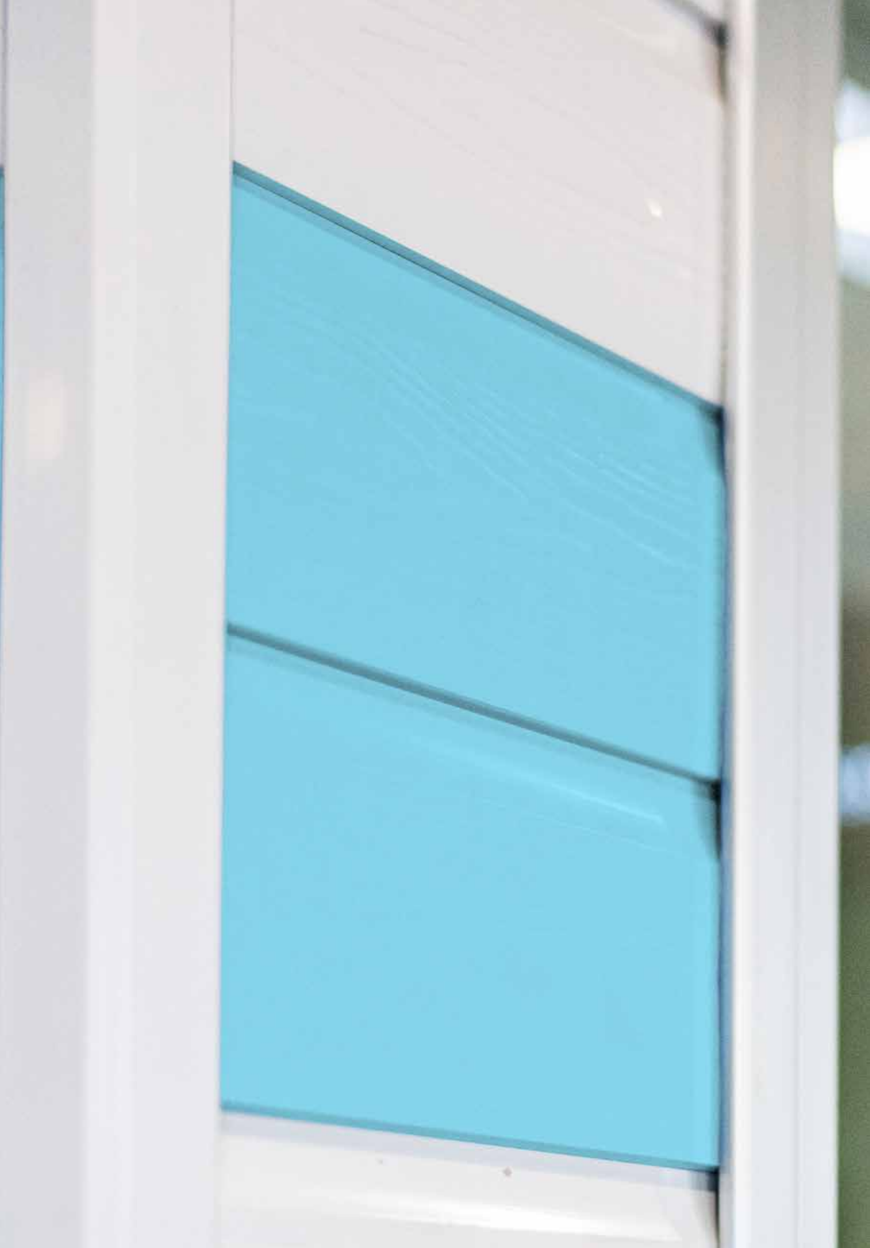
A Sinistra - Installazione di Profilo Angolare su ISOMUR - Bianco Matt On the Left - Horizontal Wall Installation - ISOMUR - White Matt
